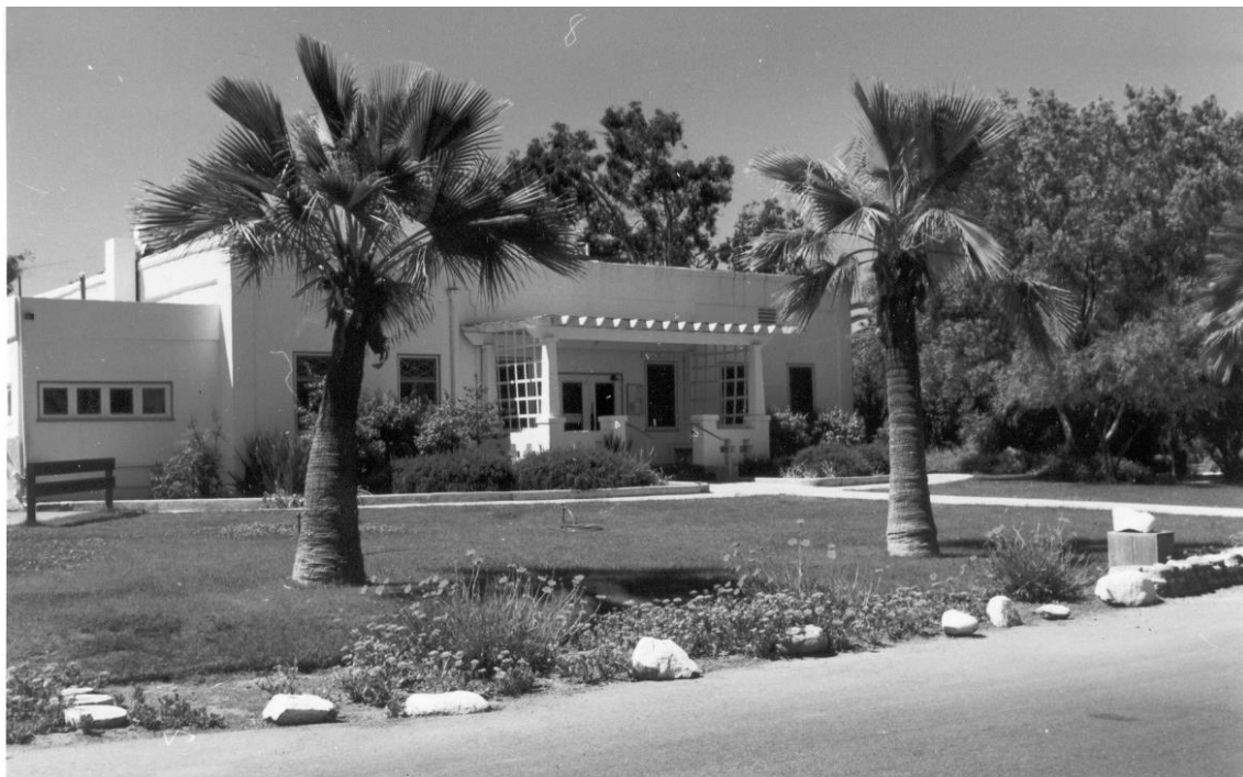
Fig. 93 – Refeitório ou Cafeteria, após a reforma
