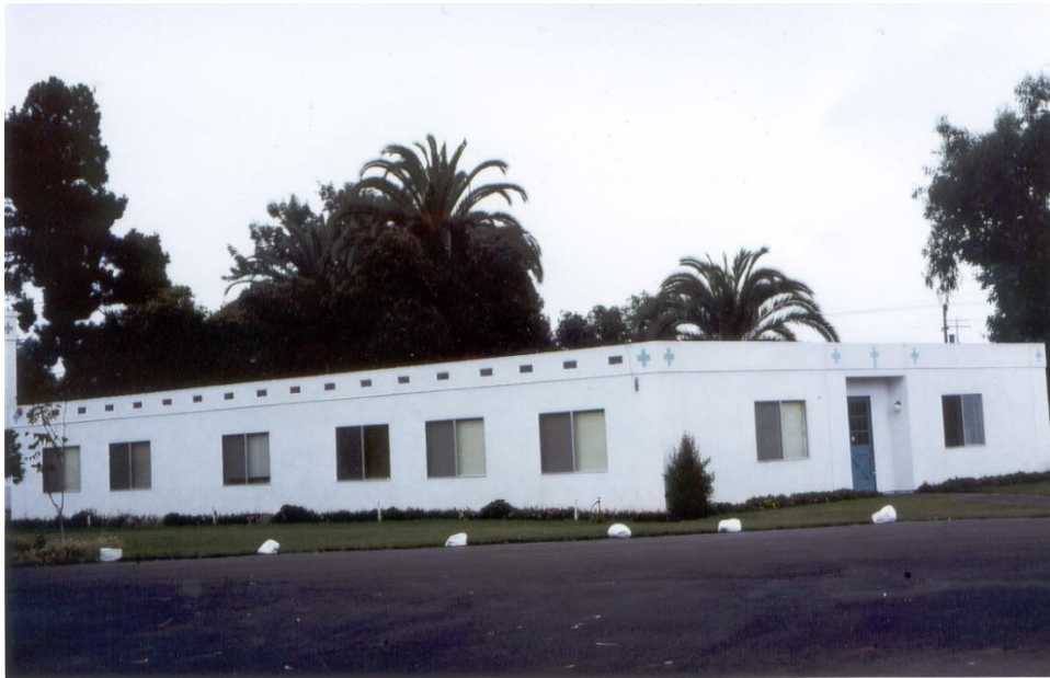
Fig. 99 – O prédio novo da administração, 1975
