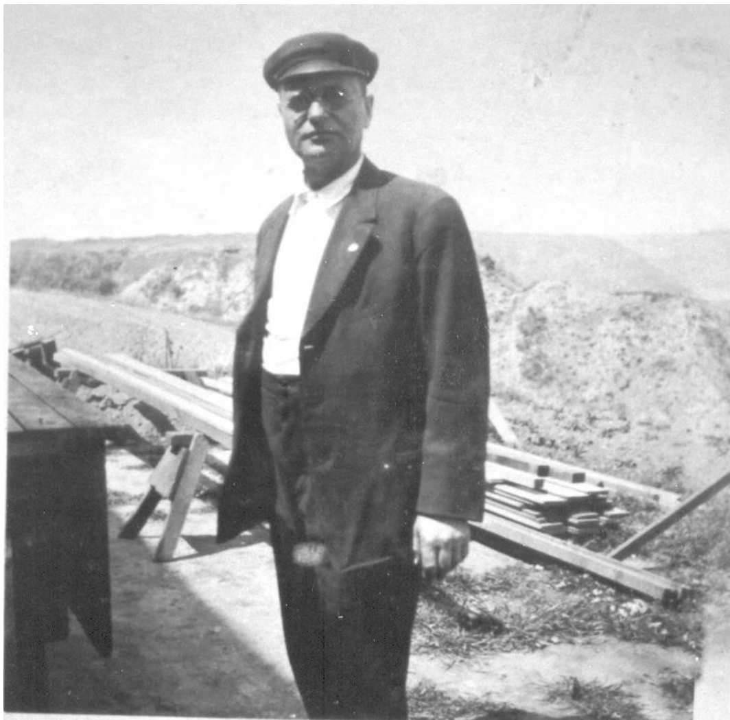
Fig. 64 – Max Heindel durante as atividades de construção em 1913
