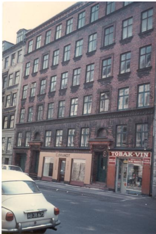
Fig. 38 – Moradia em Copenhagen, Viborggade 12
